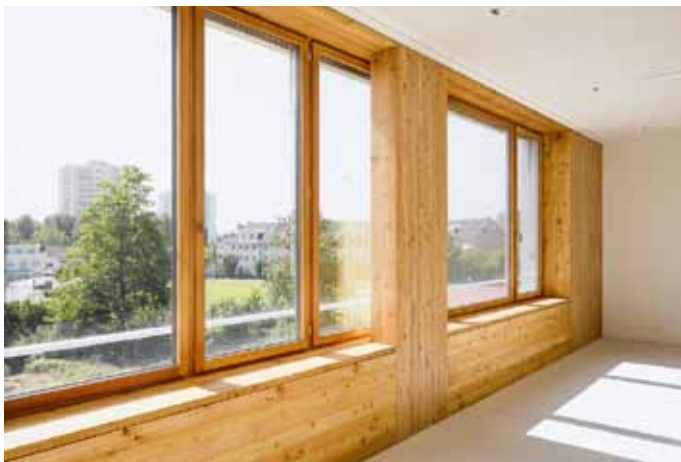
Brüstung, Stützen und Fenster aus Lärche ergeben in den Klassenzimmern ein harmonisches Bild. / Balustrades, supports and windows made from larch wood give the classrooms a harmonious look.
