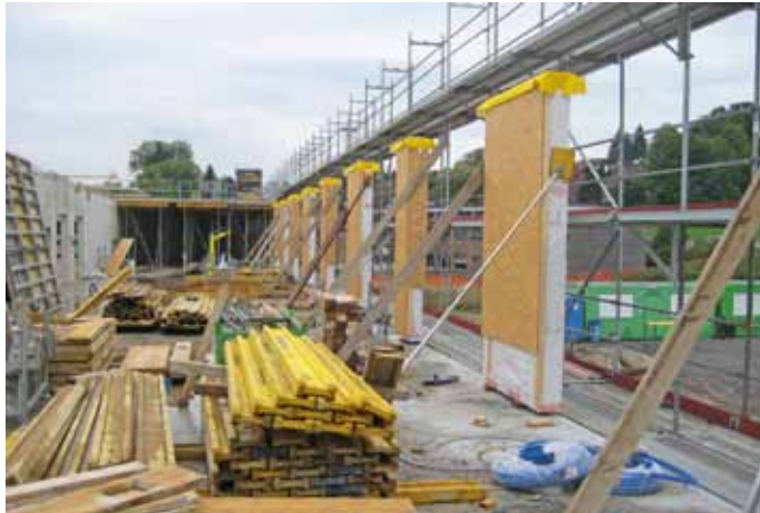
Betonplatten für die Geschosse werden von Brett-schichtverleimten Stützen aus Lärchenholz getragen. | Concrete slabs are supported by glue-laminated supports made from larch wood.
